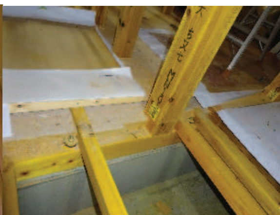
軸組、根太工法の UFO—E ナット
