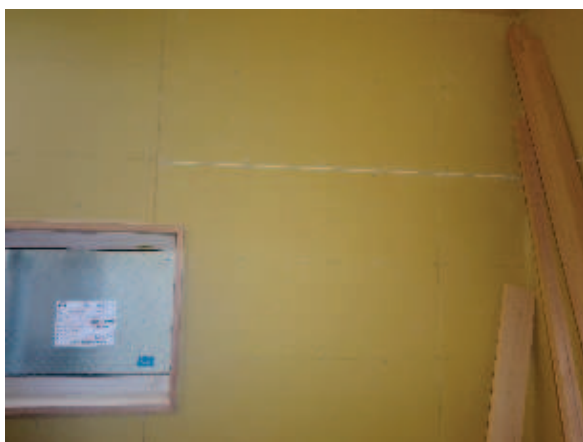
ボードに変状無し
