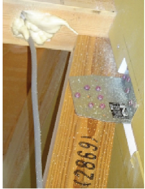
基礎廻りは異常なし
