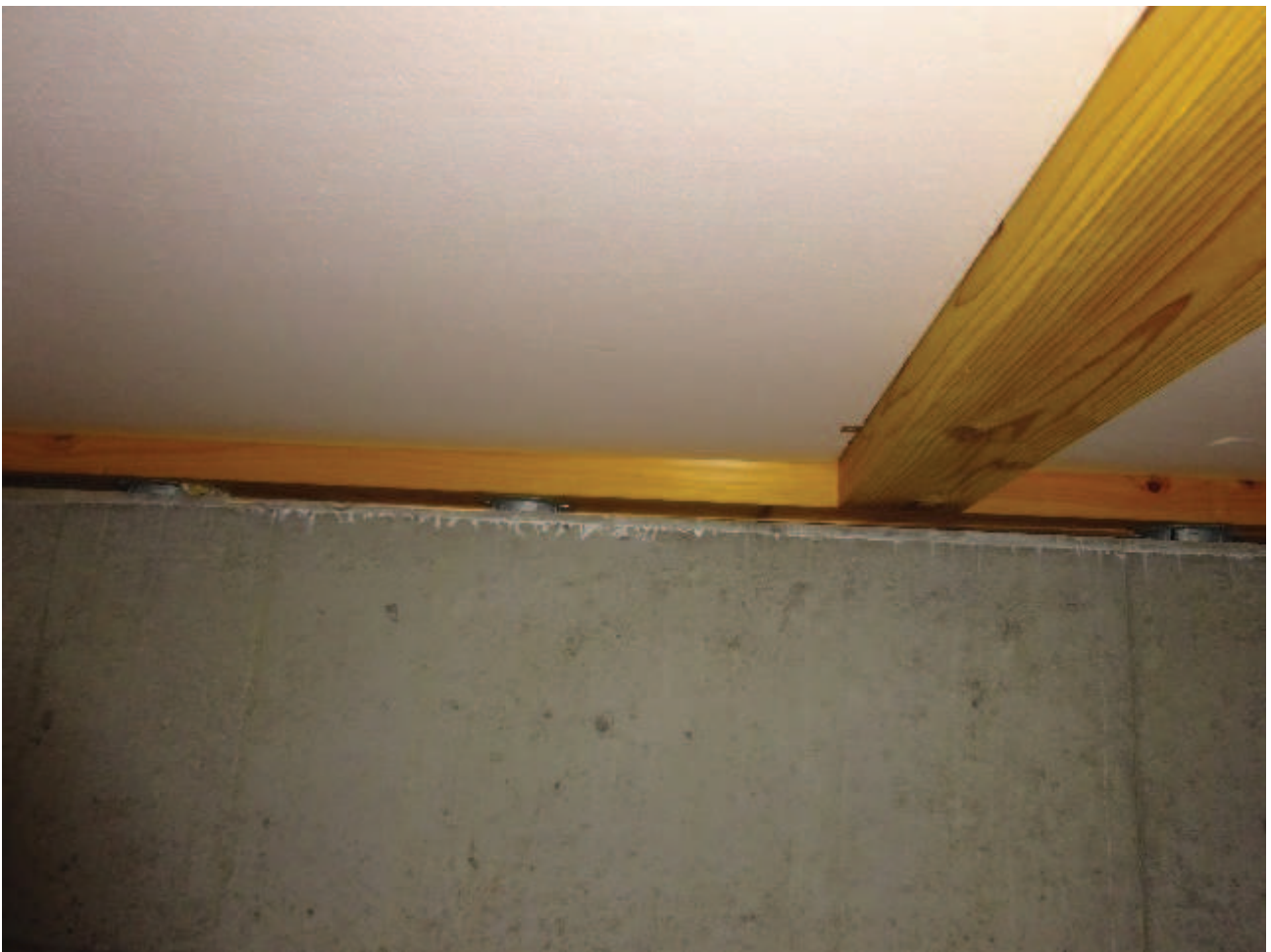
UFO-EV は変状無しゴムバンドは切れている
